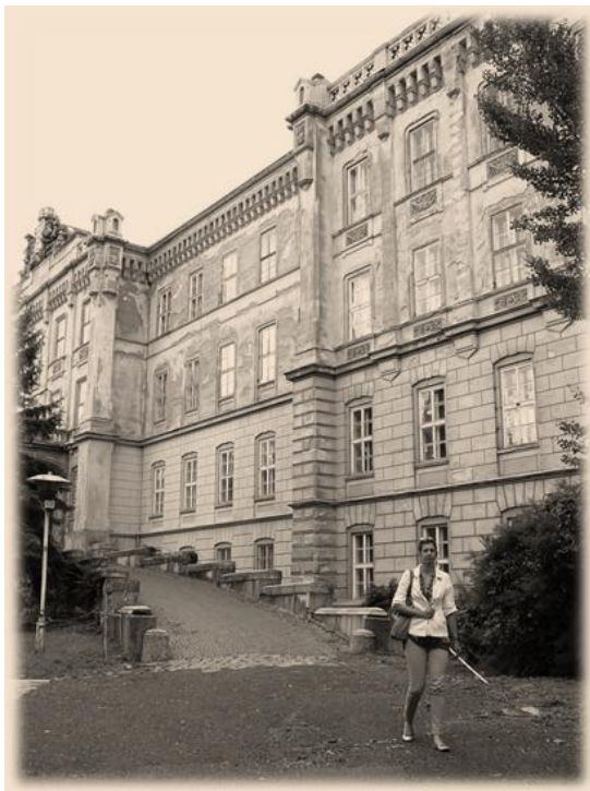
A főépület főhomlokzata (forrás: saját készítésű kép)
