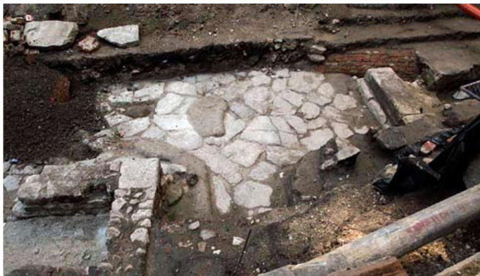
A Borostyánkő út rekonstrukciója Sopronban (kép: https://www.muemlekiem.hu/magazin/sopron_fo_ter_rekonstrukcio_borostyanko_ut )
